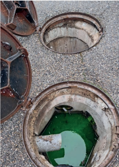
Traçage des écoulements des eaux usées
